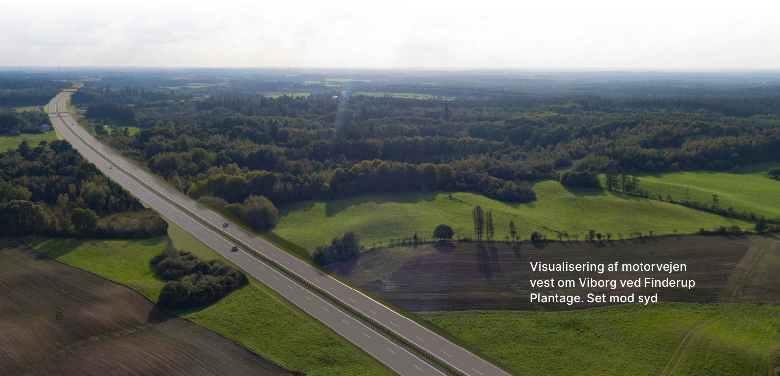
Figur 1. Motorvejen har to spor og et nødspor i hver kørselsretning.
